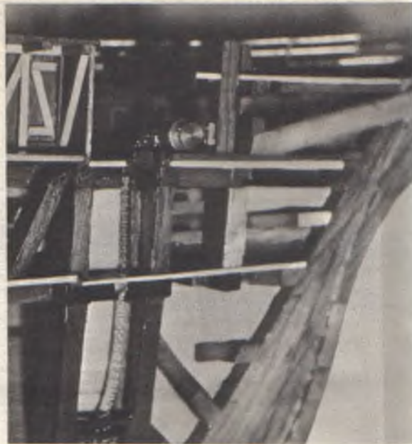
Abb. 5 Theone-Modell des Verlassers aus dem Verkehrsmuseum; Schnittseite vorn; Bug mit Spriet, Ankerwinde und Kettenkasten
